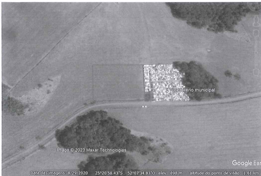
Foto 01 Imagem aérea do terreno (imagem Google)
