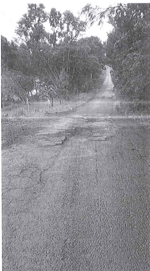
Imagens 10 e 11 – Asfalto danificado
