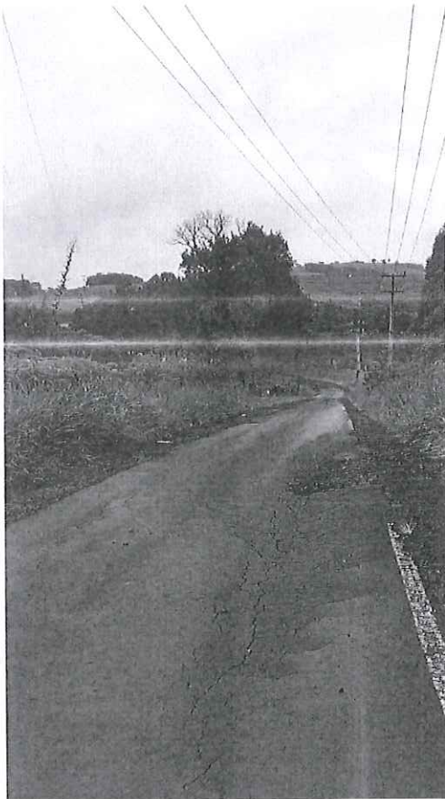
Imagens 6 e 7 – Asfalto danificado
